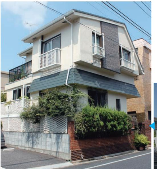
既存屋根は瓦調屋根材とスレート瓦が混在していたが、今回は全面を金属屋根材（一部カバー工法を採用）で仕上げた。低層部の化粧屋根（庇）は既存スレート瓦を新しい屋根材と同じ色で塗装し直している。
