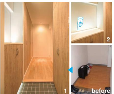
1.玄関および廊下に設けた壁面収納は、オリーブの木目が美しい面材を全面に使用。奥行きは35cmでマンション特有の梁型を巧みに隠している。縮小した玄関タタキは、共用廊下から連続する既存タイルを流用。
