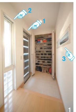
1.玄関ドア脇に設けた縦長スリット窓(2)は、下をガラスブロック、上は風を採り込める小窓(収納可能なロール式戸付き)とした。右手に見えるのがキッチンとの間仕切り壁に設けた横長スリット窓(3)。
