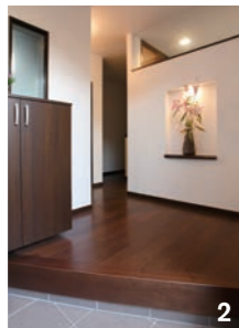
2. 玄関側から見た新設壁。上部のガラスからリビングの光を玄関に採り込み、玄関も明るく清々しい空間になった。
