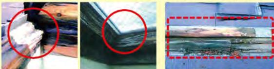
天窓の枠の腐食 ガラスの熱割れ 屋根下地材の腐食
