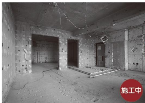
構造体のみを残して壁と天井を取り除き、 スケルトン状態になった室内
